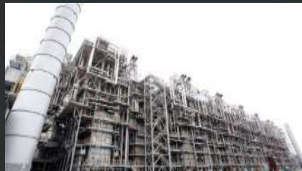
석유화학 Plant 단열재
