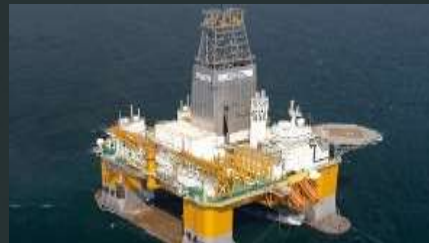
해양 Plant 단열재
